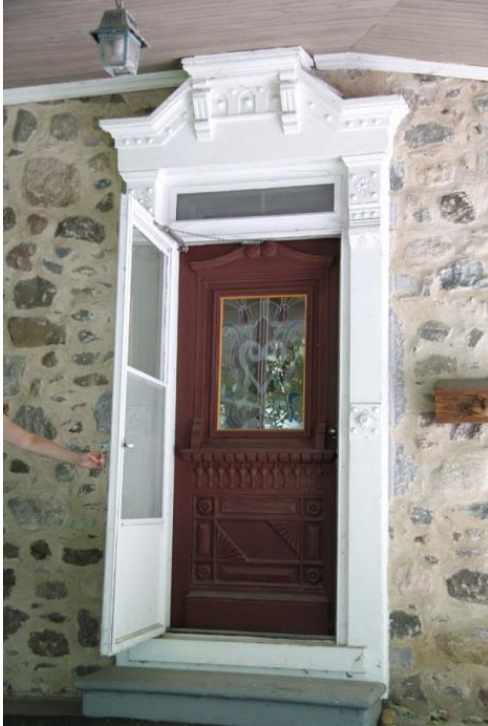
Porte en menuiserie d'assemblage munie d'une corniche tout à fait exceptionnelle. Maison Chrétien-Zaugg 15, rue Pierre-Boucher
