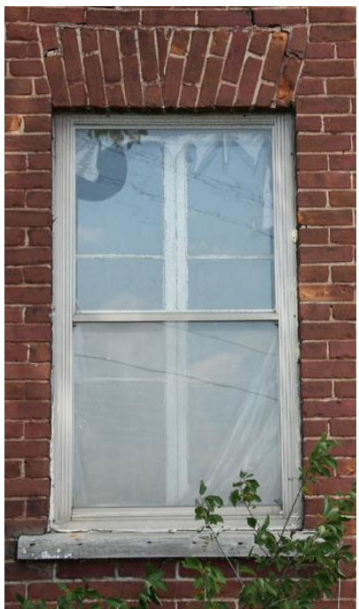
Fenêtre à battants à 4 grands carreaux 440, chemin de Bretagne
