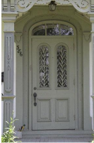
Porte en menuiserie d'assemblage avec vitrage à imposte en anse de panier 386, boulevard Marie-Victorin
