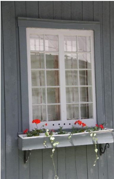
Fenêtre à battants à 20 petits carreaux avec chambranles 11, rue De La Perrière Nord
