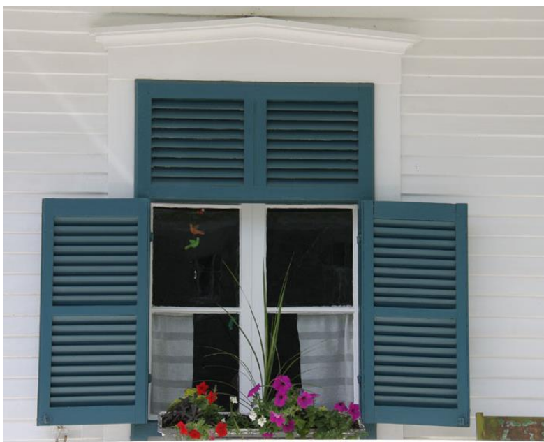
Fenêtre à battants à grands carreaux à imposte, avec persiennes 3-5, rue De La Perrière Nord
