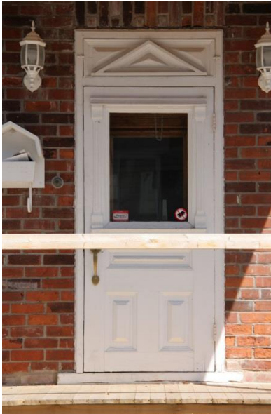
Porte en menuiserie d'assemblage à imposte ornée d'un fronton. Une corniche surmonte la baie vitrée 544, rue Sainte-Marguerite
