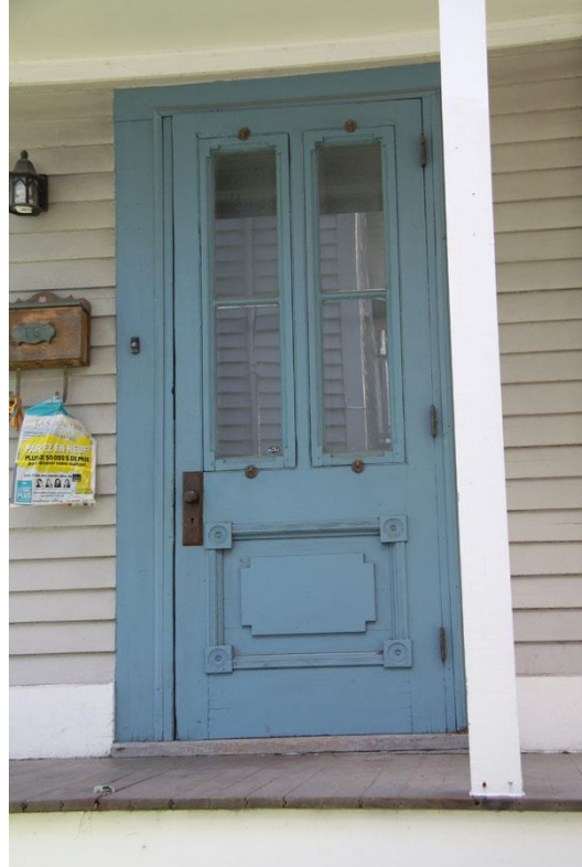
Porte à menuiserie d'assemblage avec vitrage à carreaux 14, boulevard De Montarville
