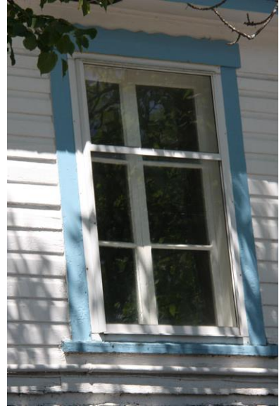
Fenêtre à battants à 6 grands carreaux 49-51, rue De Grandpré
