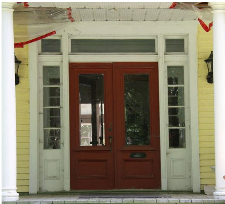
Porte en menuiserie d'assemblage, à doubles battants, avec imposte et baies latérales à carreaux 426, boulevard Marie-Victorin
