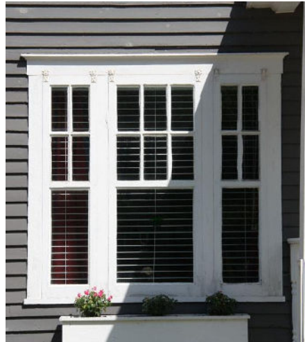
Fenêtre à guillotine à petits-bois à baies latérales 516, rue Saint-Charles
