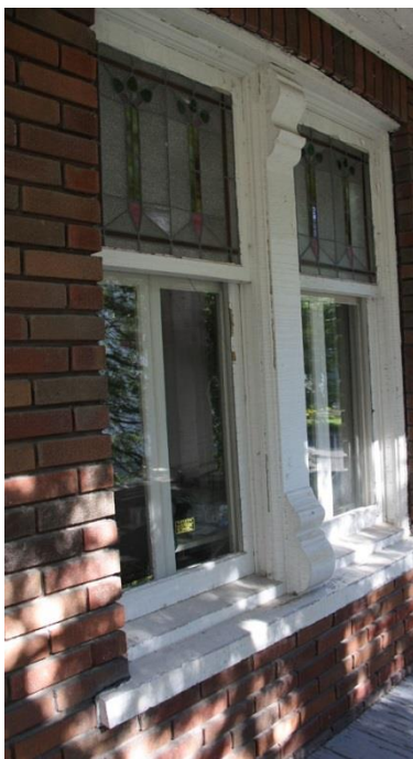
Fenêtres jumelées à battants à imposte avec vitrail et à meneau ouvragé 587, rue Saint-Charles
