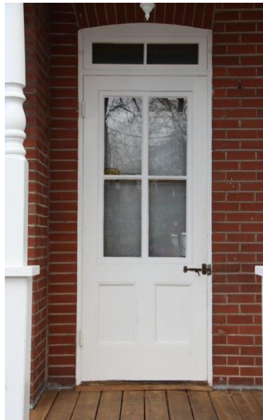
Porte en menuiserie d'assemblage à vitrage à petits carreaux
