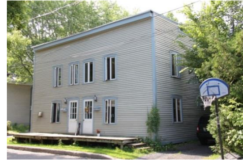
Exemple de maison à toit plat 36-38, rue De La Perrière Nord
