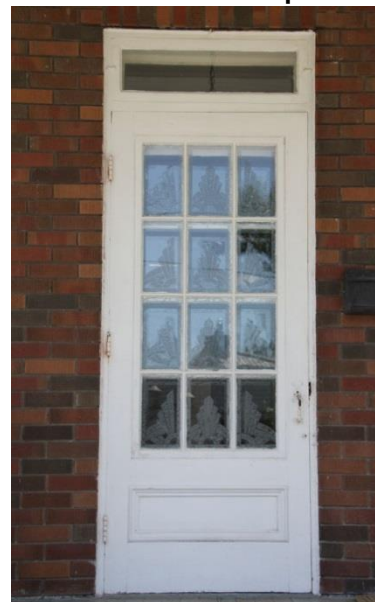
Porte en menuiserie d'assemblage à vitrage à 12 petits carreaux et à imposte 462, rue Samuel-Provost
