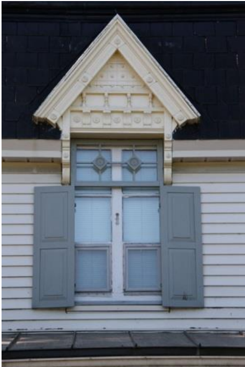
Fenêtre de lucarne à battants à grands carreaux 38, rue Louis-H.-La Fontaine Nord
