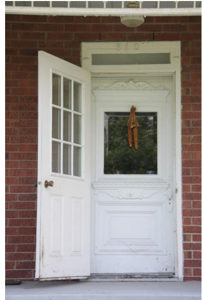
Porte en menuiserie d'assemblage et à imposte 810, chemin du Général-Vanier
