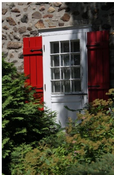
Porte en menuiserie d'assemblage avec vitrage à petits carreaux 466, boulevard Marie-Victorin
