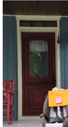
Porte en menuiserie d'assemblage avec vitrage en arc surbaissé 582, boulevard Marie-Victorin
