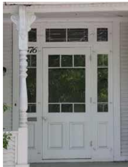
Porte en menuiserie d'assemblage à imposte et baies latérales 376, boulevard Marie-Victorin
