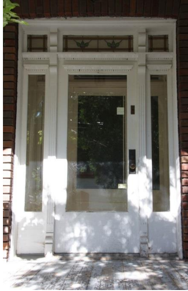
Porte en menuiserie d'assemblage à imposte à vitraux et baies latérales 587, rue Saint-Charles
