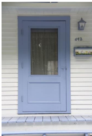
Porte en menuiserie d'assemblage avec vitrage et à un seul carreau 642, rue Sainte-Famille
