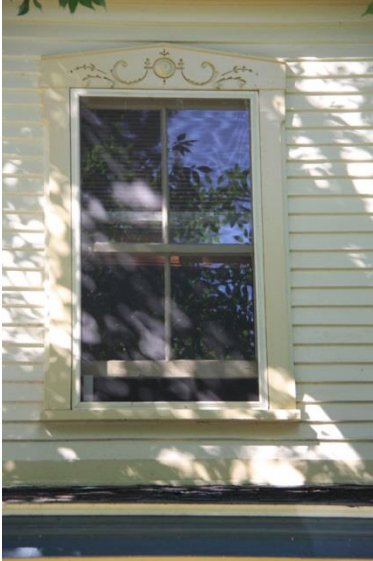
Fenêtre à guillotine à petits-bois 17, rue Guérin
