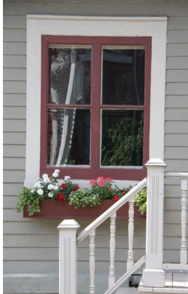
Fenêtre à battants à 4 grands carreaux dotée d'un chambranle 16, rue De La Perrière Nord
