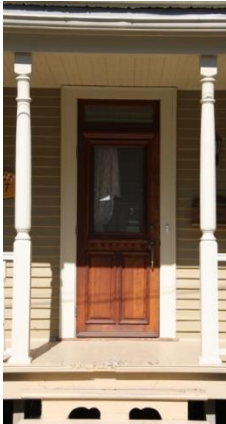
Porte en menuiserie d'assemblage avec vitrage et à imposte 517, rue Saint-Charles
