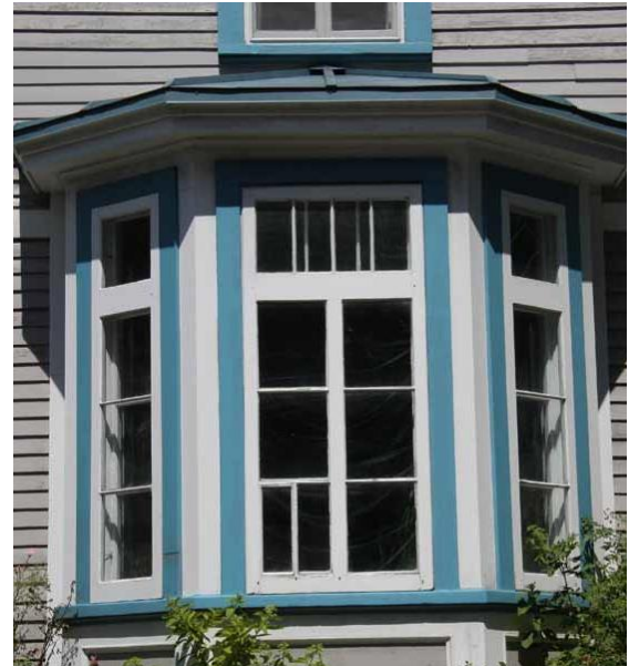
Fenêtre en saillie (logette à 3 pans) 14, boulevard De Montarville
