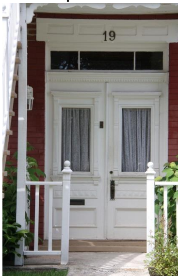
Porte à doubles battants, avec vitrage et panneaux 19-21, rue De La Perrière Nord
