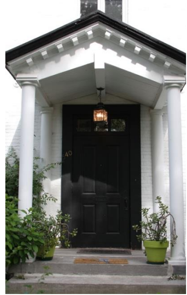
Porte en menuiserie d'assemblage avec vitrage avec imposte à carreaux 540, rue Notre-Dame
