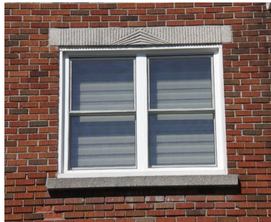
Fenêtres à guillotine jumelées 569-569 A, rue Saint-Sacrement
