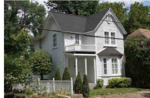
Exemple de maison vernaculaire 16, rue Desmarteau
