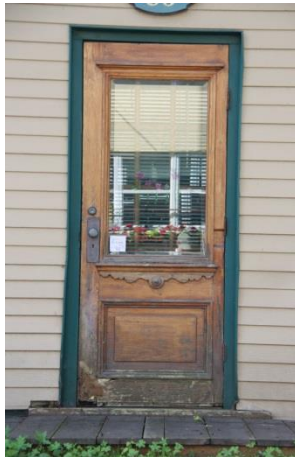
Porte en menuiserie d'assemblage dont le vitrage est souligné par une moulure 38, rue De Montbrun
