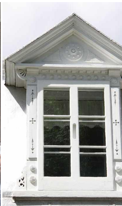
Fenêtre de lucarne à battants à 6 grands carreaux 7, rue De La Perrière Nord
