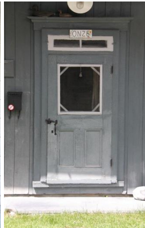
Porte en menuiserie d'assemblage avec vitrage et à imposte 11, rue De La Perrière Nord
