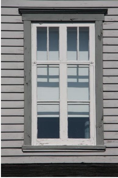
Fenêtre à battants à grands carreaux. Les carreaux supérieurs avec leurs petits-bois s'apparentent à une imposte 50, rue De Grosbois
