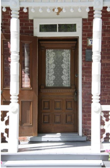
Porte en menuiserie d'assemblage et à imposte 7, rue De La Perrière Nord
