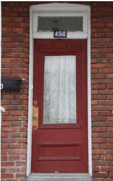
Porte en menuiserie d'assemblage à vitrage et à un seul panneau
