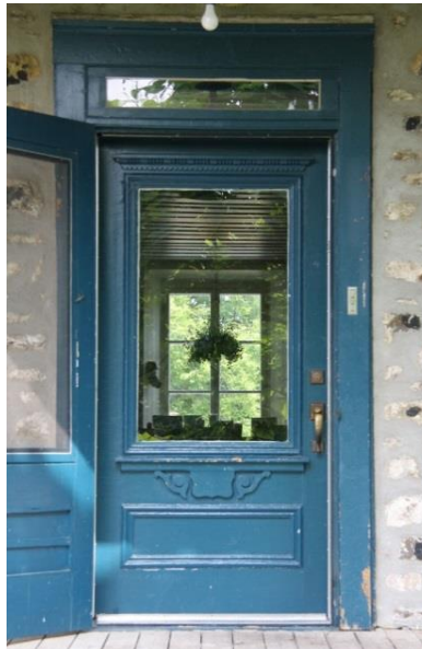
Une porte en menuiserie d'assemblage où la baie vitrée est soulignée par une moulure 1201, rang Lustucru
