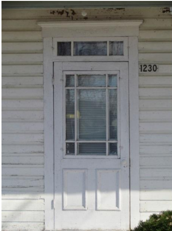
Porte à menuiserie d'assemblage à vitrage carrelé et à imposte Collection Bergeron Gagnon inc.
