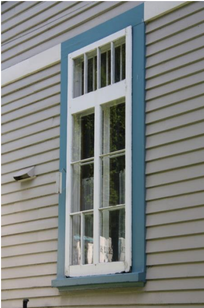
Fenêtre à battants à grands carreaux et à imposte à petits-bois 14, boulevard De Montarville
