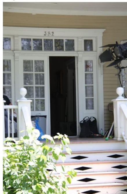
Porte en menuiserie d'assemblage, à doubles battants, avec imposte et baies latérales à carreaux 382, boulevard Marie-Victorin
