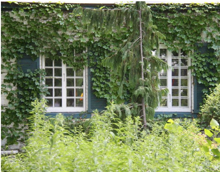
Fenêtre à battants à 24 petits carreaux 432, boulevard Marie-Victorin
