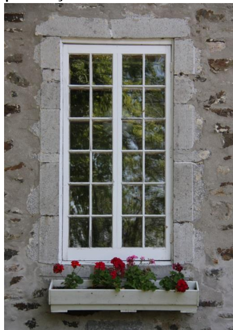
Fenêtre à battants à 24 petits carreaux 470, boulevard Marie-Victorin
