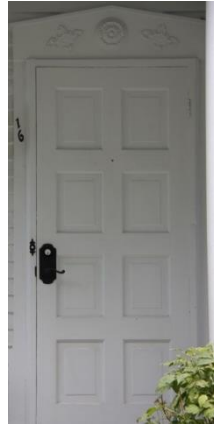
Porte en menuiserie d'assemblage sans vitrage 16, rue Desmarteau
