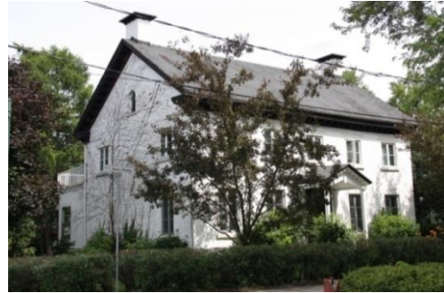
Exemple de maison de style néoclassique 540, rue Notre-Dame
