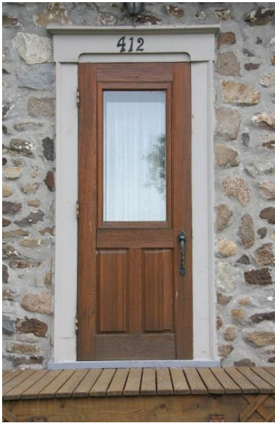
Porte en menuiserie d'assemblage avec vitrage et panneaux verticaux 412, boulevard Marie-Victorin
