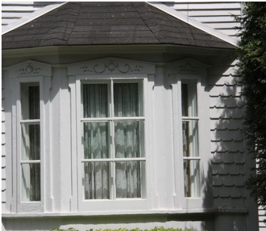
Fenêtre à battants à 6 grands carreaux dans une logette 16, rue Desmarteau
