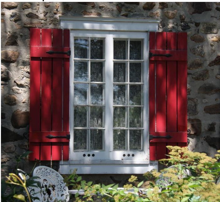
Fenêtre à battants à 20 petits carreaux 466, boulevard Marie-Victorin
