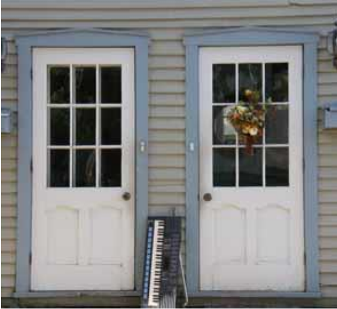
Ensemble de portes en menuiserie d'assemblage à vitrage à petits carreaux 36-38, rue De La Perrière Nord
