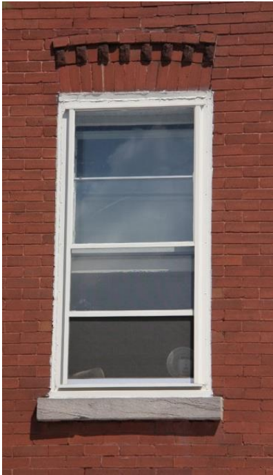
Fenêtre à guillotine simple et arc en brique 528, rue Saint-Charles
