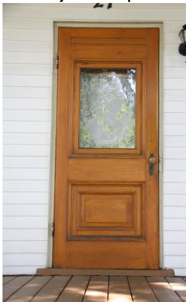
Porte en menuiserie d'assemblage à vitrage à carreau unique 27, rue De Montbrun
