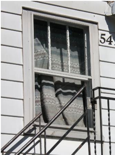
Fenêtre à battants à grands carreaux. Les carreaux supérieurs avec leurs petits-bois s'apparentent à une imposte 50, rue De Grosbois
