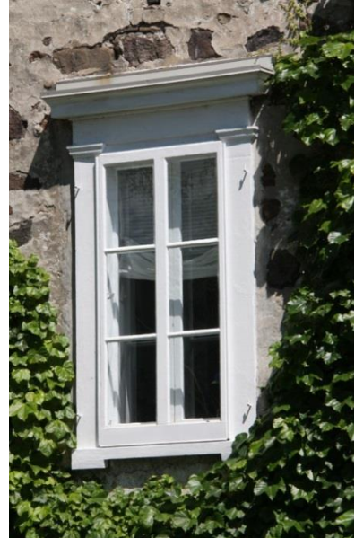
Fenêtre à battants à 6 grands carreaux avec corniche 601, boulevard Marie-Victorin
