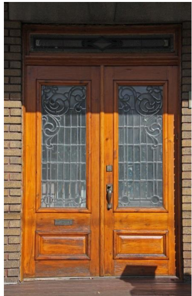
Porte en menuiserie d'assemblage à doubles battants
