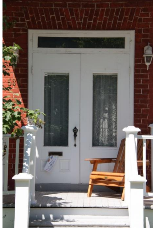
Porte à doubles battants et à imposte 531, rue Notre-Dame
