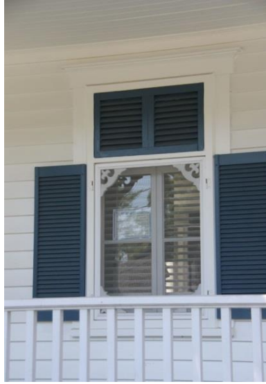
Fenêtre à battants à grands carreaux à imposte 595, boulevard Marie-Victorin
