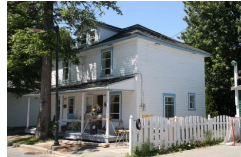
Exemple de maison de forme cubique à toit en pavillon 49-51, rue De Grandpré
