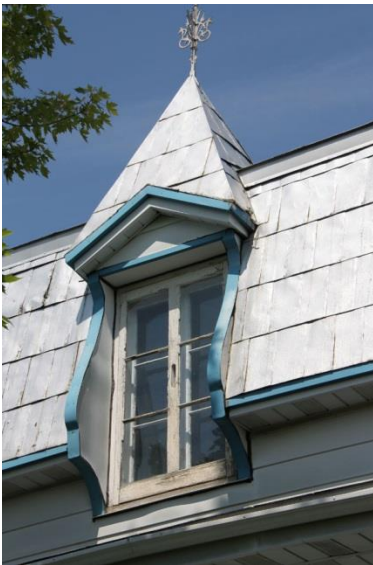
Fenêtre de lucarne à battants à 6 grands carreaux 1201, chemin du Général-Vanier
