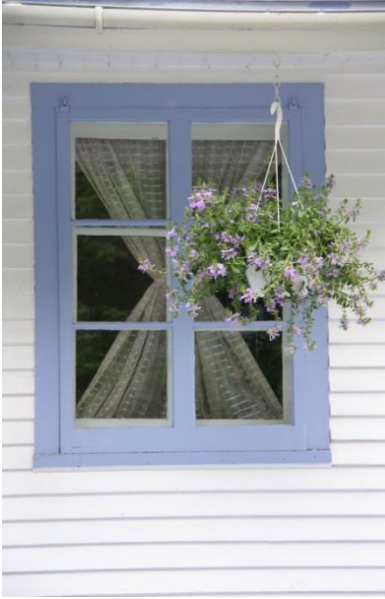
Fenêtre à battants à 6 grands carreaux avec chambranles 642, rue Sainte-Famille
