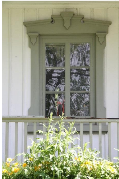
Fenêtre à battants à grands carreaux avec corniche et chambranles 386, boulevard Marie-Victorin
