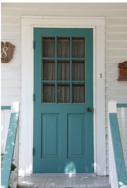
Porte en menuiserie d'assemblage à vitrage à 9 carreaux 8-10, boulevard De Montarville
