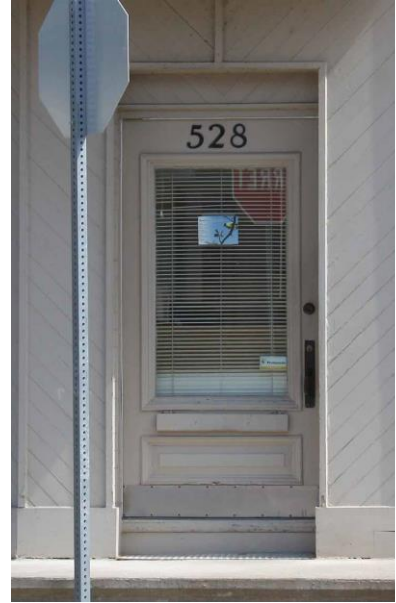
Porte en menuiserie d'assemblage à vitrage 528, rue Saint-Charles
