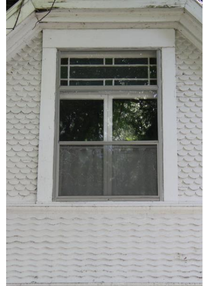
Fenêtre à battants à imposte 376, boulevard Marie-Victorin
