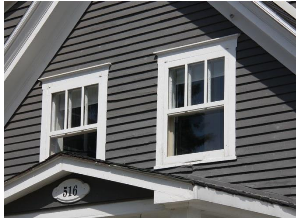
Fenêtre à battants à 8 grands carreaux 516, rue Saint-Charles
