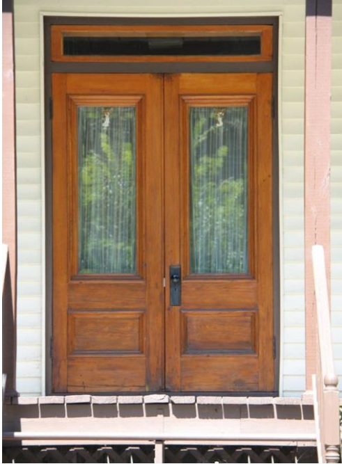
Porte à doubles battants 22, boulevard De Montarville
