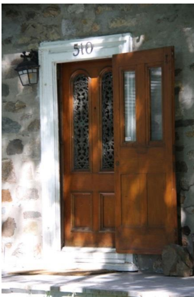
Porte menuiserie d'assemblage avec vitres en arc plein cintre 510, boulevard Marie-Victorin
