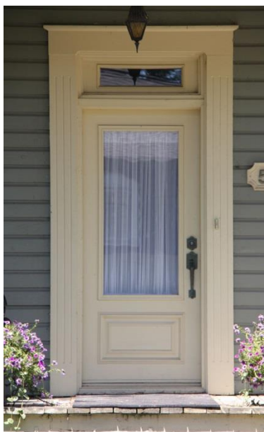
Porte en menuiserie d'assemblage à vitrage et à carreau unique, surmontée d'une imposte 589, boulevard Marie-Victorin
