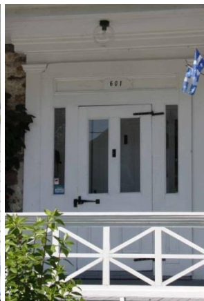
Porte en menuiserie d'assemblage avec vitrage et à baies latérales 601, boulevard Marie-Victorin
