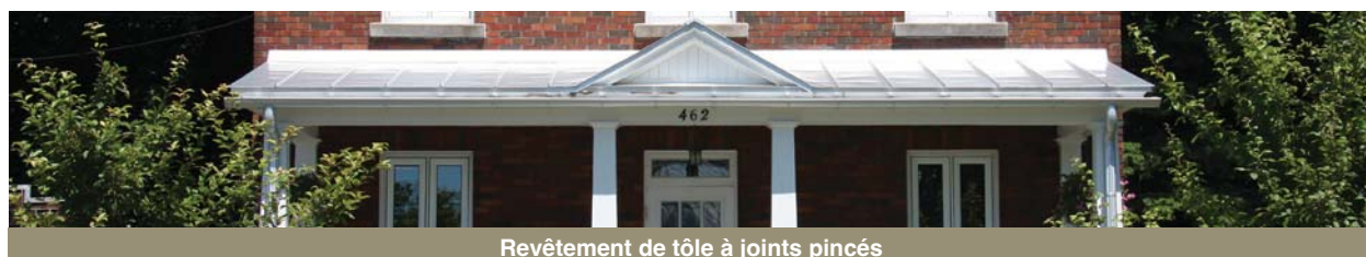
Revêtement de tôle à joints pincés
