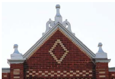
Le couronnement au centre de la façade peut être agrémenté d'un jeu de briques.
