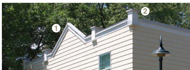
Un couronnement ①, des amortissements ② et un traitement de la corniche en bandeau ③ décorent la partie supérieure de la façade.
