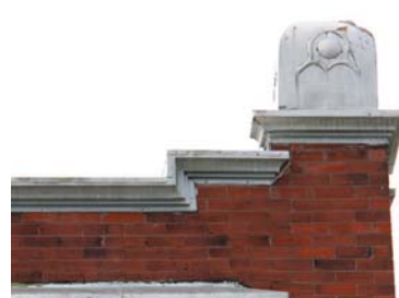
Un amortissement peut décorer les extrémités de la façade.
