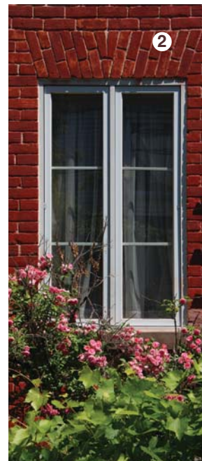
Revêtement de brique. Au-dessus des ouvertures, on distingue un linteau ❶ ou une plate-bande ❷.
