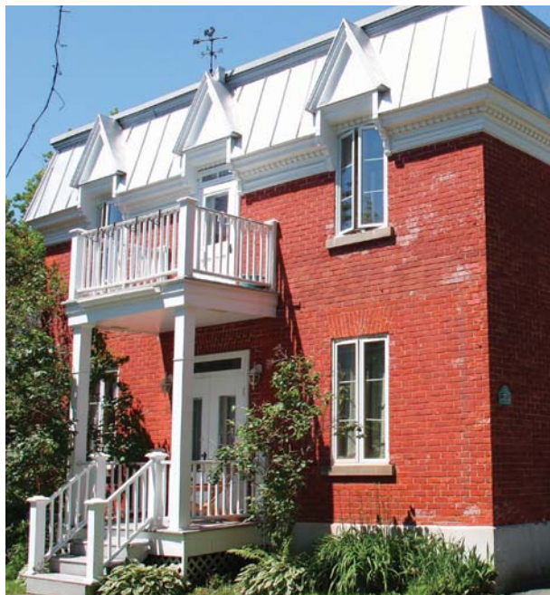
Revêtement de brique. Au-dessus des ouvertures, on distingue un linteau ❶ ou une plate-bande ❷.
