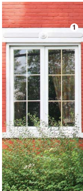
Revêtement de brique. Au-dessus des ouvertures, on distingue un linteau ❶ ou une plate-bande ❷.
