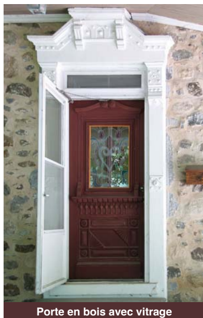
Porte à double battants avec vitrage, surmontée d'une imposte.
