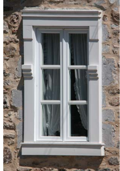
Fenêtre à battants et à grands carreaux
