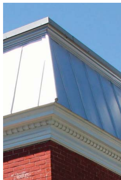
Revêtement de tôle à joints pincés
