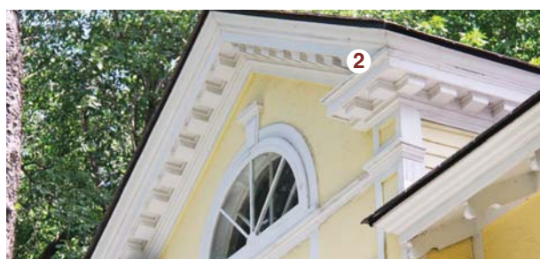
Les soffites et les fascias sont très moulurés et peuvent recevoir des consoles ❶ et une corniche ❷.
