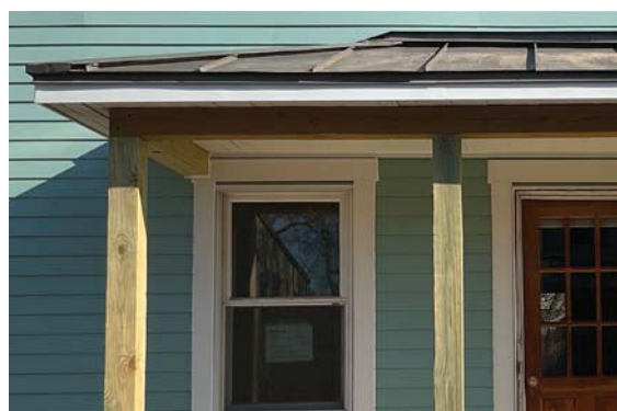
Revêtement de tôle à joints pincés
