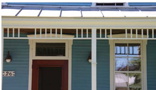
Revêtement de tôle à joints pincés
