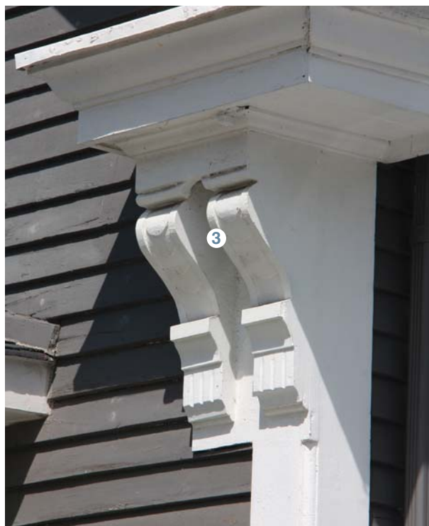
Des éléments décoratifs faits de bois découpé animent le bâtiment : aisseliers ①, lambrequins ② et consoles ③.
