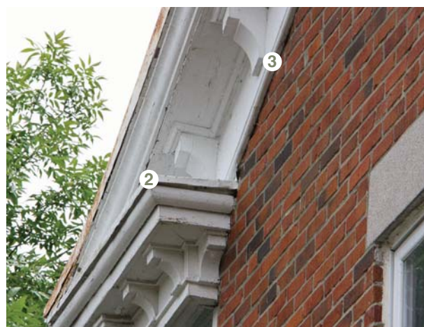
Le retour de la corniche ② et la corniche ③ viennent décorer la bordure de la toiture.
