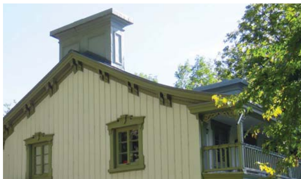
Les deux souches de cheminées sont positionnées à chaque extrémité de la toiture.
