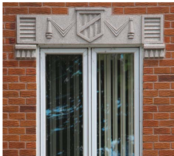
Les ouvertures sont entourées d'un chambranle décoratif ou d'un linteau en maçonnerie.
