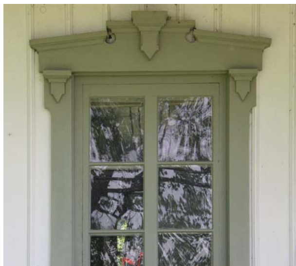
Les ouvertures sont entourées d'un chambranle décoratif ou d'un linteau en maçonnerie.
