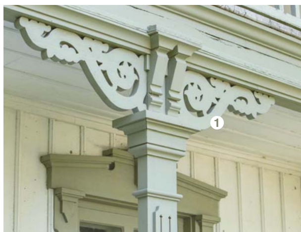
Le sommet des colonnes des balcons peut être orné d'aisseliers ①.
