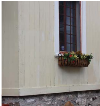
Revêtement de planches unies posées à la verticale
