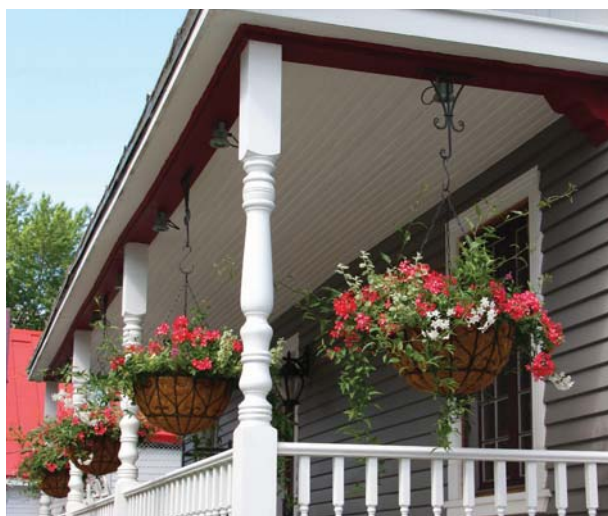
Le prolongement de la toiture peut être supporté par des colonnes décoratives en bois. Dans certains cas, des aisseliers ❶ ornent la partie supérieure des colonnes.
