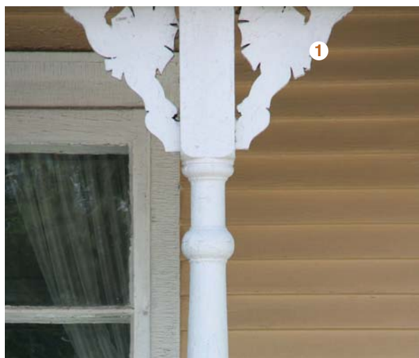
Le prolongement de la toiture peut être supporté par des colonnes décoratives en bois. Dans certains cas, des aisseliers ❶ ornent la partie supérieure des colonnes.
