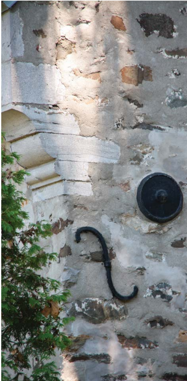
Esse composée d'une tige et d'une ancre en métal servant de système d'ancrage aux murs de pierre.
