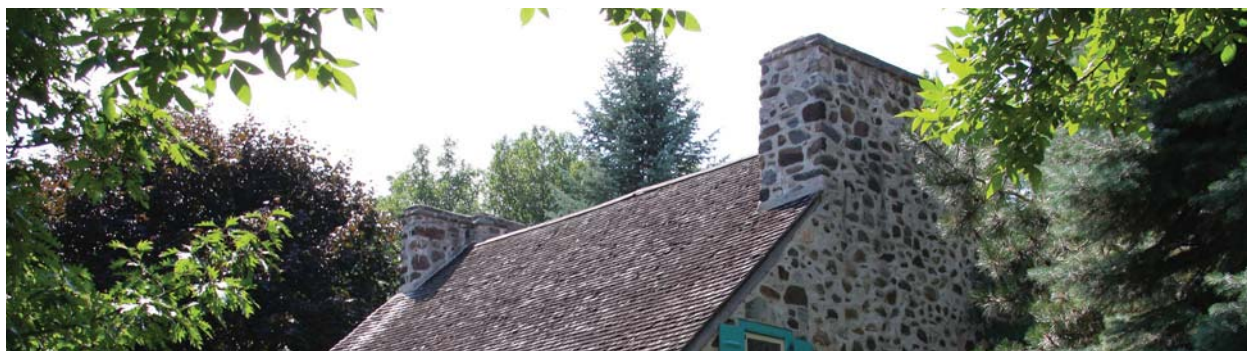
Cheminées en pierre massive positionnées à chaque extrémité du toit. Ici, les cheminées s'intègrent dans le prolongement des murs pignons.
