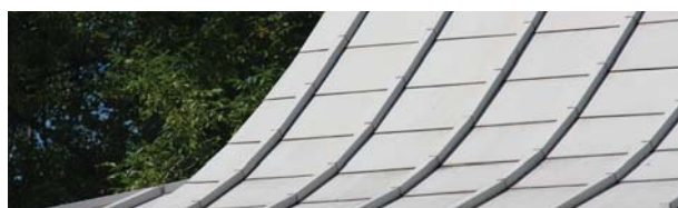
Revêtement de tôle à baguettes et revêtement de tôle à joints pincés
