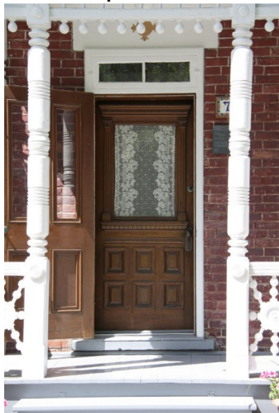
Porte en menuiserie d'assemblage et imposte
