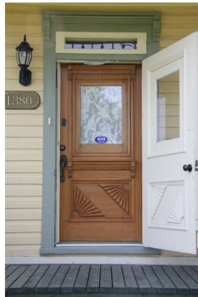
Porte en menuiserie d'assemblage et à imposte
