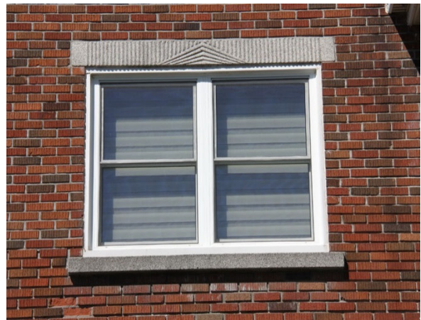
Fenêtres à guillotine jumelées 569-569 A, rue Saint-Sacrement
