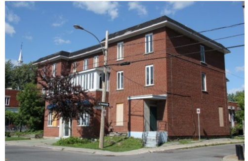
Exemple d'architecture commerciale 536, boulevard Marie-Victorin
