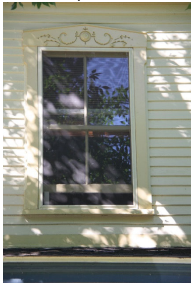
Fenêtre à guillotine à petits-bois 17, rue Guérin
