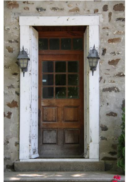
Porte en menuiserie d'assemblage avec vitrage à carreaux, surmontée d'une imposte
