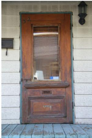
Porte en menuiserie d'assemblage avec vitrage
