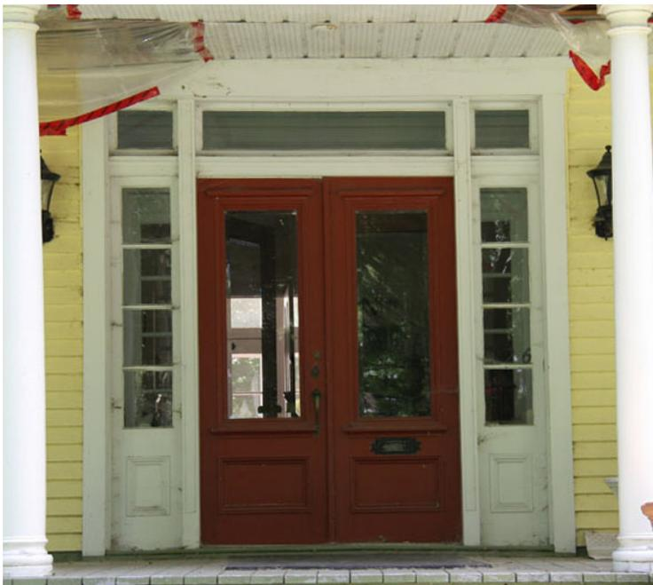
Porte en menuiserie d'assemblage, à doubles battants, avec imposte et baies latérales à carreaux
