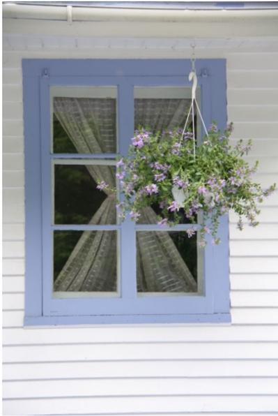
Fenêtre à battants à 6 grands carreaux avec chambranles
