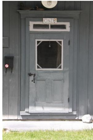
Porte en menuiserie d'assemblage avec vitrage et à imposte
