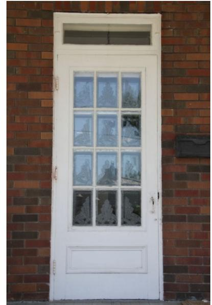
Porte en menuiserie d'assemblage à vitrage
