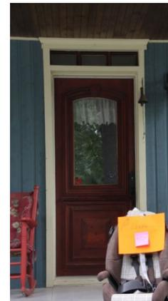
Porte en menuiserie d'assemblage avec vitrage en arc surbaissé
