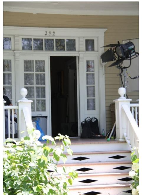
Porte en menuiserie d'assemblage, à doubles battants, avec imposte et baies latérales à carreaux
