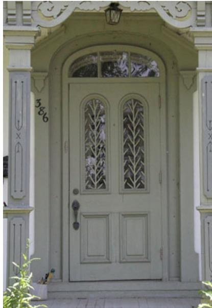
Porte en menuiserie d'assemblage avec vitrage à imposte en anse de panier
