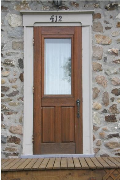
Porte en menuiserie d'assemblage avec vitrage et panneaux verticaux
