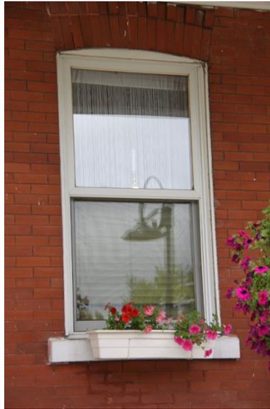
Fenêtre à guillotine et arc surbaissé en brique
