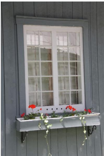
Fenêtre à battants à 20 petits carreaux avec chambranles
