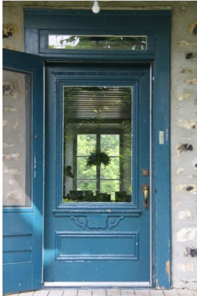
Une porte en menuiserie d'assemblage où la baie vitrée est soulignée par une moulure
