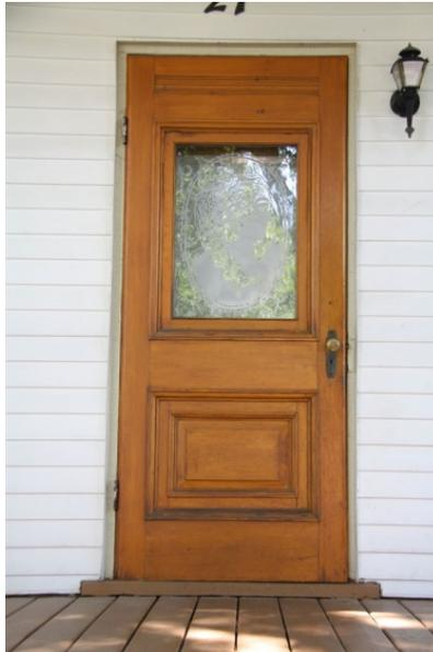
Porte en menuiserie d'assemblage à vitrage
