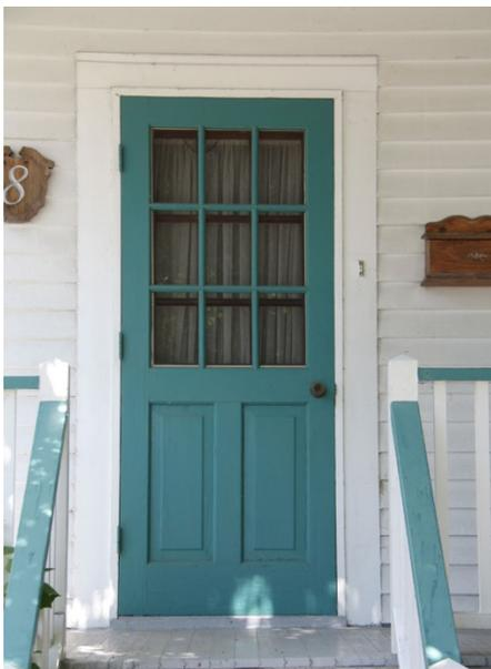
Porte en menuiserie d'assemblage à vitrage à
