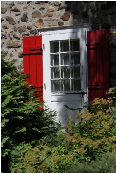
Porte en menuiserie d'assemblage avec vitrage à petits carreaux
