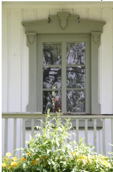
Fenêtre à battants à grands carreaux avec corniche et chambranles
