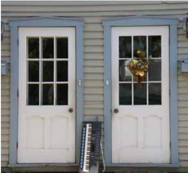
Ensemble de portes en menuiserie d'assemblage à vitrage à petits carreaux
