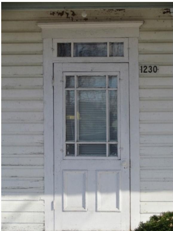
Porte à menuiserie d'assemblage à vitrage carrelé et à imposte
