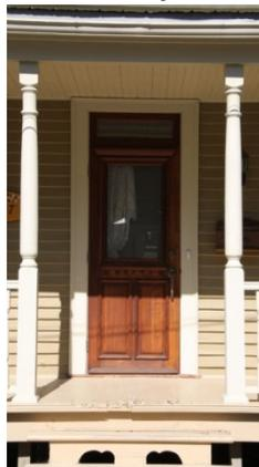
Porte en menuiserie d'assemblage avec vitrage et à imposte
