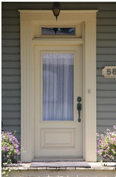
Porte en menuiserie d'assemblage à vitrage
