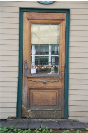
Porte en menuiserie d'assemblage dont le vitrage est souligné par une moulure
