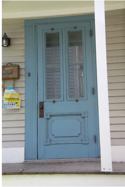
Porte à menuiserie d'assemblage avec vitrage à carreaux
