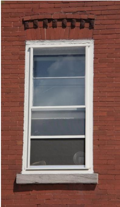
Fenêtre à guillotine simple et arc en brique
