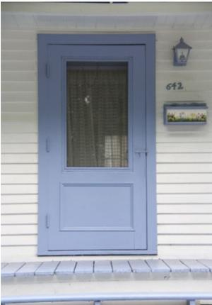
Porte en menuiserie d'assemblage avec vitrage et à un seul carreau
