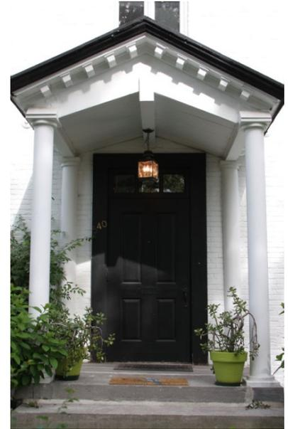
Porte en menuiserie d'assemblage avec vitrage avec imposte à carreaux
