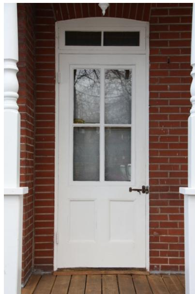
Porte en menuiserie d'assemblage à vitrage
