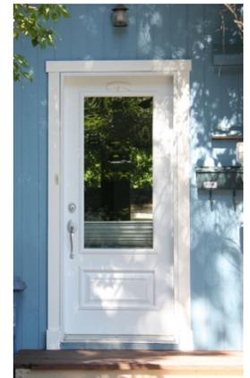
Porte en menuiserie d'assemblage avec vitrage et à large imposte
