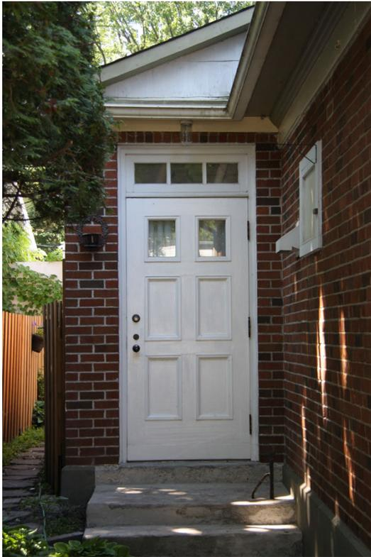
Porte à menuiserie d'assemblage et à imposte
