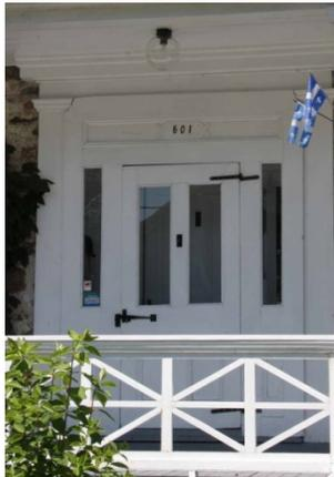
Porte en menuiserie d'assemblage avec vitrage et à baies latérales
