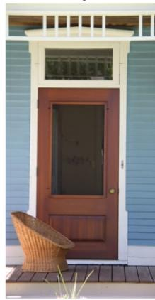
Porte en menuiserie d'assemblage avec vitrage et à large imposte
