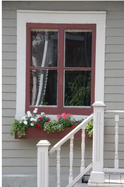
Fenêtre à battants à 4 grands carreaux dotée d'un chambranle
