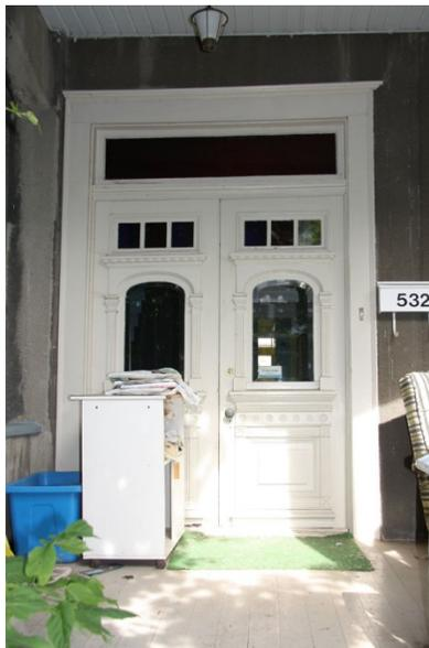
Porte en menuiserie d'assemblage à doubles battants et à imposte
