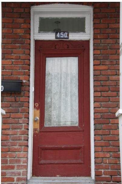
Porte en menuiserie d'assemblage à vitrage
