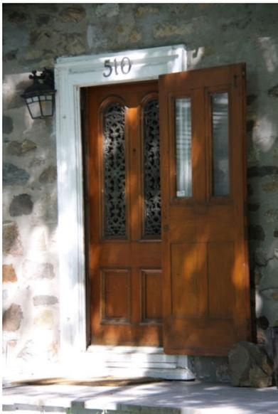
Porte menuiserie d'assemblage avec vitres en arc plein cintre
