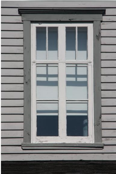
Fenêtre à battants à grands carreaux. Les carreaux supérieurs avec leurs petits-bois s'apparentent à une imposte
